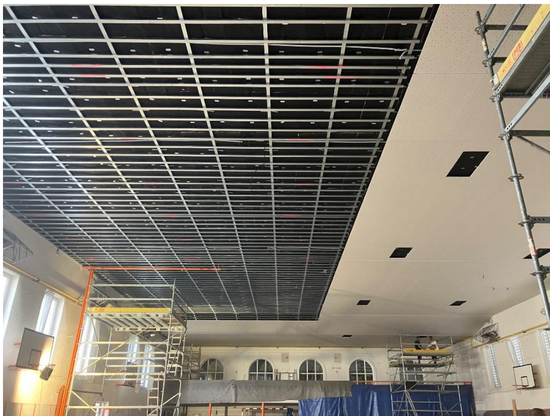
Ze života školy – rekonstrukce stropních podhledů v tělocvičně
