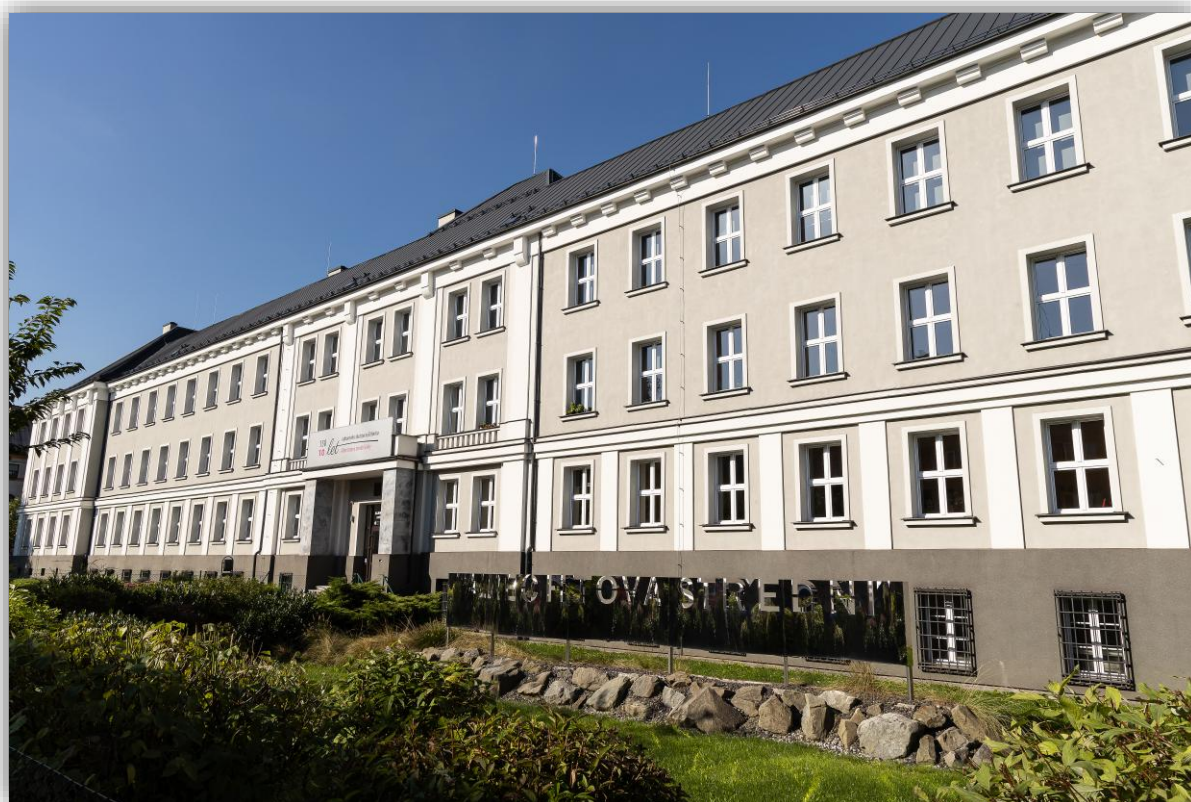
Hlavní budova školy – ulice Tyršova
