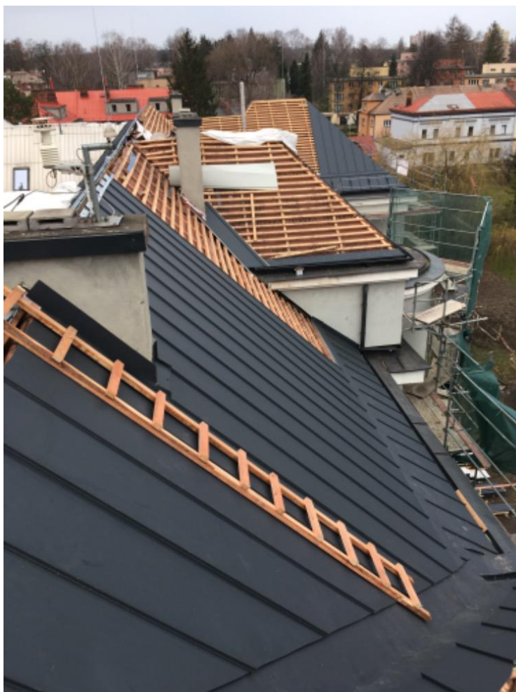
Práce na výměně střešní krytiny
