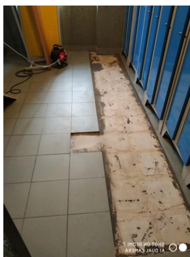
Práce na opravách a údržbě školy
