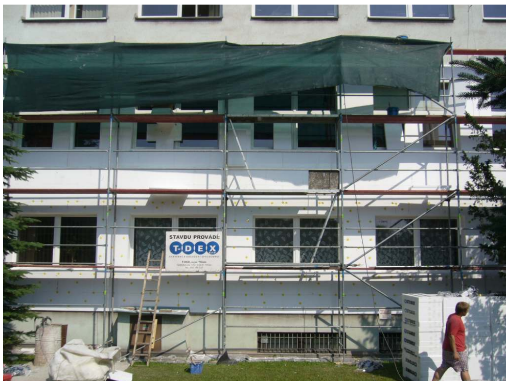
foto: budova školy Frýdecká 32 - zateplování fasády
